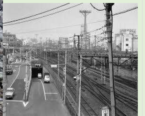
開通当時の隧道
